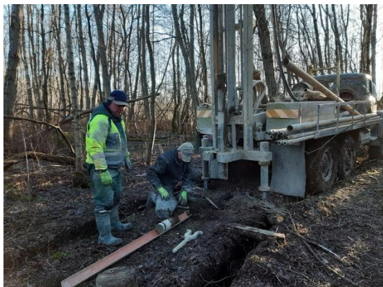
Foto 4.1. Südamikpuurimine (PA-2) (foto T. Tuuling, 06.02.2020, N 59°25'16" ja E 24°52'37").
